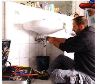
... und im Monteursanzug, wenn es etwas zu reparieren oder installieren gilt.
